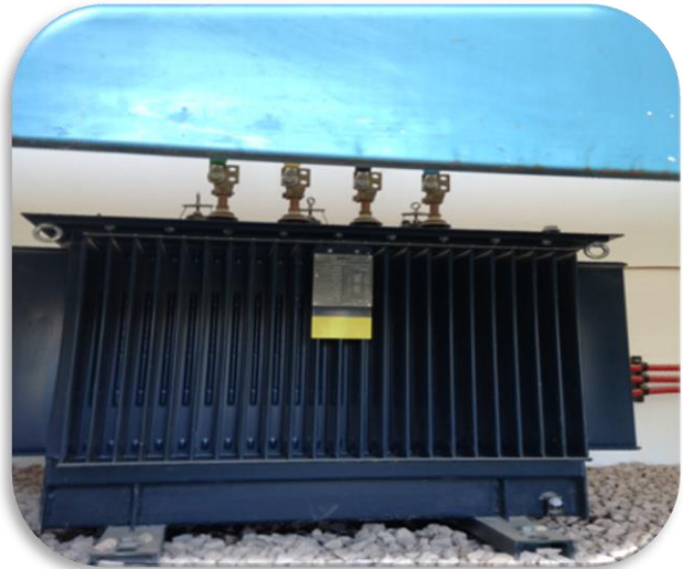
Foto 1: Imagen de un transformador eléctrico.
